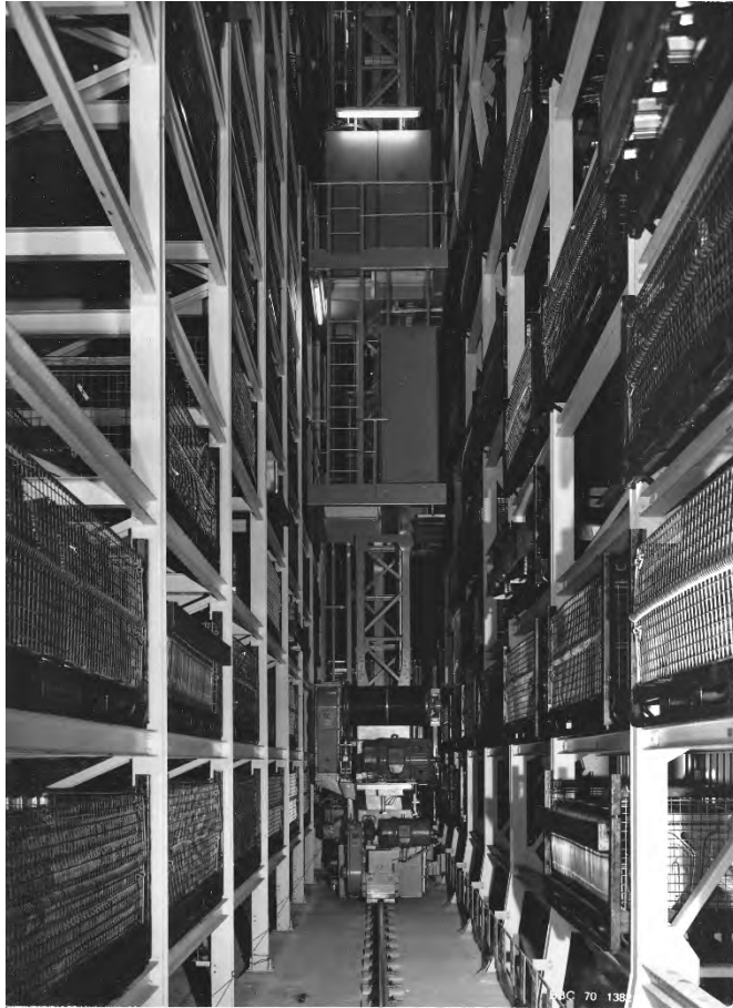
Hochregallager mit Regalförderzug
